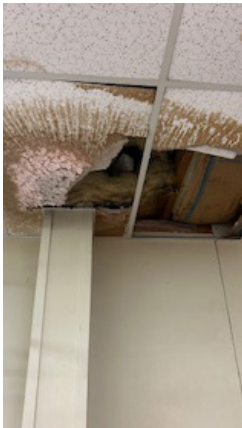
Daños del techo con goteras.
